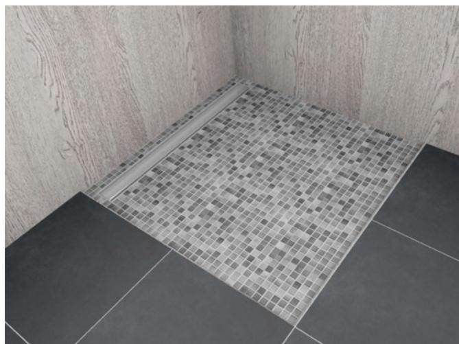
**12.** Abschließend wird das Duschelement verfliest. Das Element ist rollstuhlbefahrbar ab einem Fliesenformat von 50 x 50 mm.
