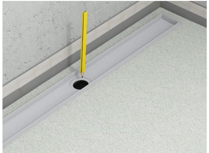
**2.** Element trocken setzen und die Position des Ablauftopfes anzeichnen. Alternativ das Achsmaß ausmessen.
