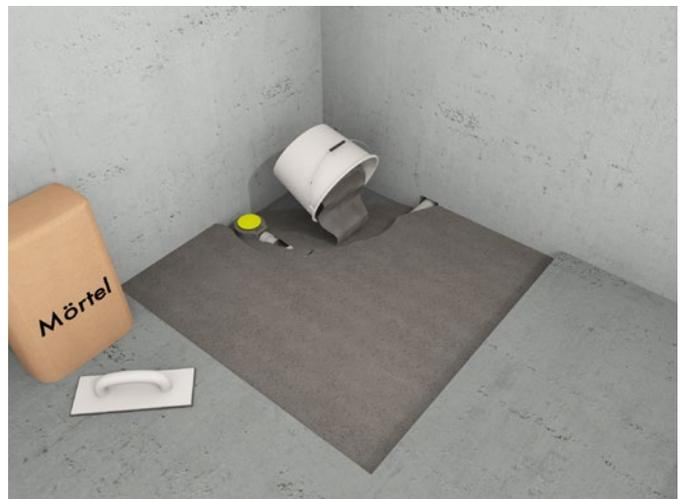
**4.** Die Bodenaussparung mit einem Ausgleichsestrich auffüllen und glatt ziehen. Alternativ können Sie den Ausgleich mit Rapid Höhenausgleichselementen von STADUR herstellen.
