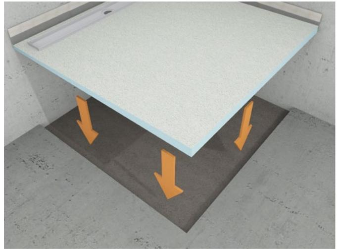
**6.** Duschelement verlegen und ausrichten.
