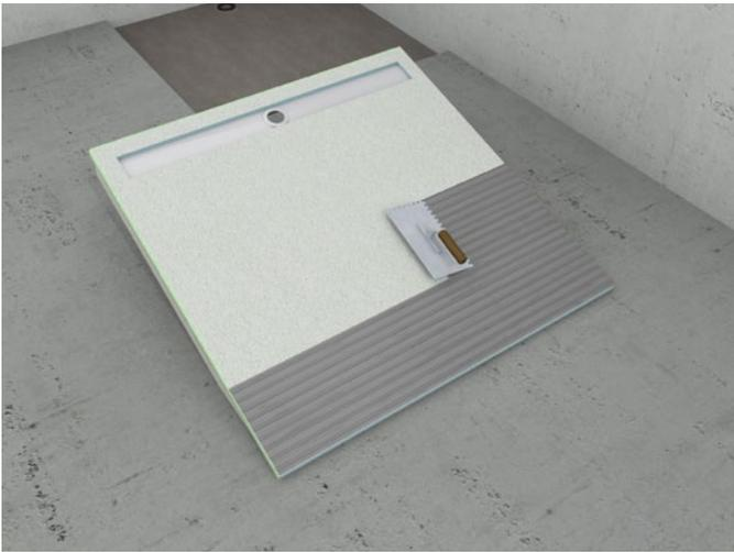
**5.** Mit einem Kammspachtel 8 mm wird Fliesenkleber (Güteklasse C2) vollflächig auf der Unterseite des Duschelementes aufgebracht.
