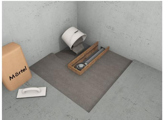
**4.** Die Bodenaussparung mit einem Ausgleichsestrich auffüllen und glatt ziehen. Alternativ können Sie den Ausgleich mit Rapid Höhenausgleichselementen von STADUR herstellen. Höhe aus Punkt 2 beachten.
