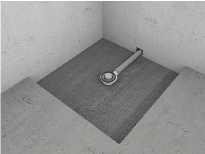
**3.** Den Ablauftopf an die vorhandene Entwässerung anschließen und entsprechend ausrichten. Verbindungen auf Dichtigkeit prüfen.
