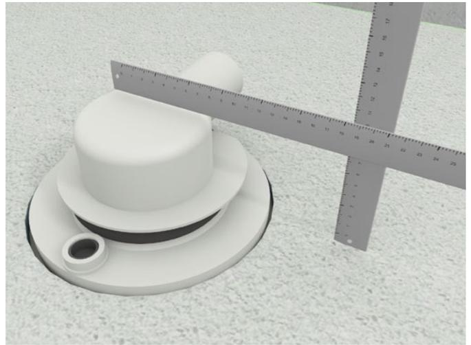
**2.** Ablauftopf trocken auf das Element aufstecken und die Höhendifferenz zwischen Unterseite Ablauftopf und Unterseite Duschelement notieren, um den benötigten Höhenausgleich zu ermitteln.
