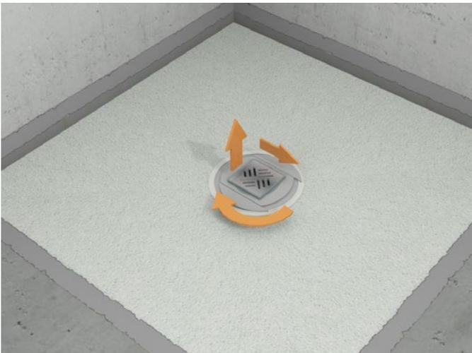
**11.** Den Rahmen mit dem Edelstahlrost einsetzen. Das Element kann nun befließt werden. Das Rost ist höhen- und seitenverstellbar und drehbar. Die Versatzhöhe kann von 7 - 16 mm angepasst werden.
