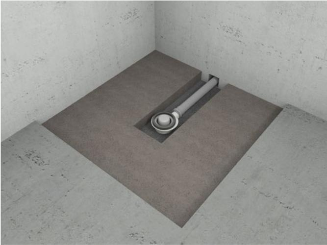
**5.** Wir empfehlen einen Bereich um Ablauftopf und Entwässerung frei zu lassen, damit der Ablauf nachträglich justiert werden kann. Der Hohlraum wird in Schritt 9 vergossen.
