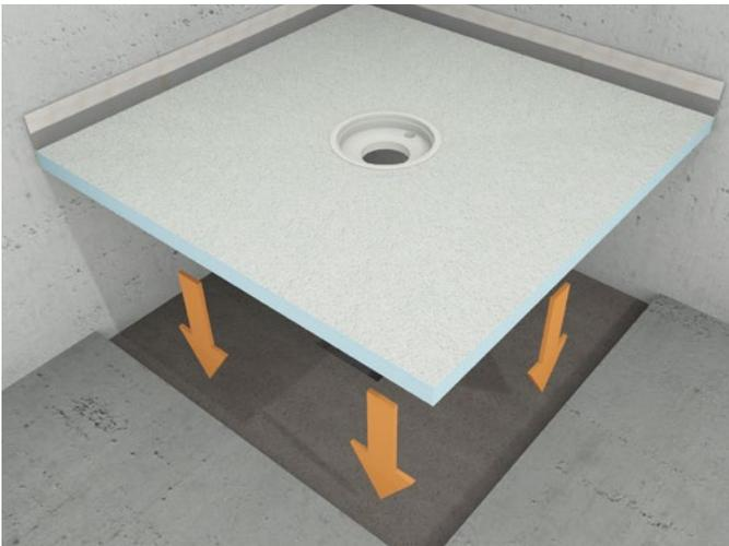
**7.** Die Gummidichtung am Ablauf mit Gleitmittel versehen. Duschelement verlegen und ausrichten.
