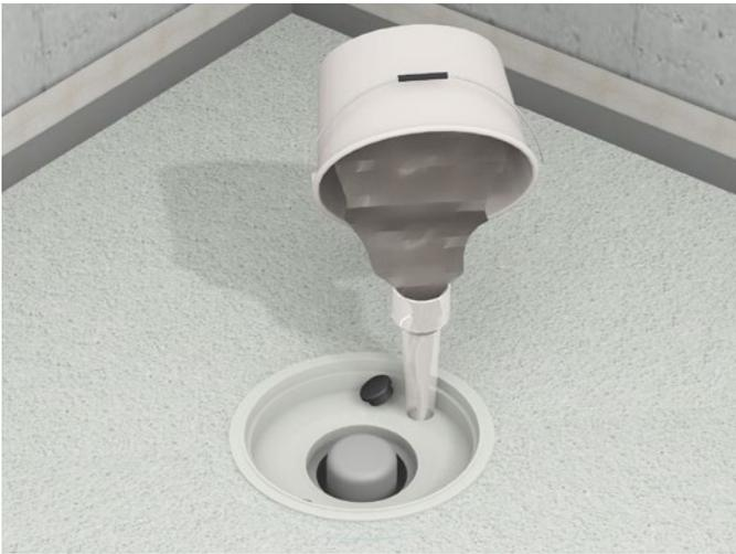
**9.** Eventuelle Hohlräume um den Ablauftopf mittels Vergussmörtel / Bohrlochsusension vergießen. Die Öffnungen sind zwingend mit den mitgelieferten Gummistopfen zu verschließen.
