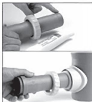
**3** Klemmstück in Bohrung einsetzen, dabei Zähne leicht zusammendrücken. Gummiring einfetten. **Fertigungsnaht zeigt nach oben.**
