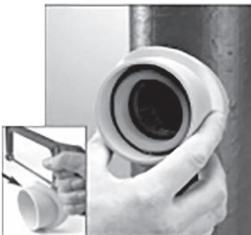
**6** Überwurfring über Rohrende schieben, Rohrende einfetten.
