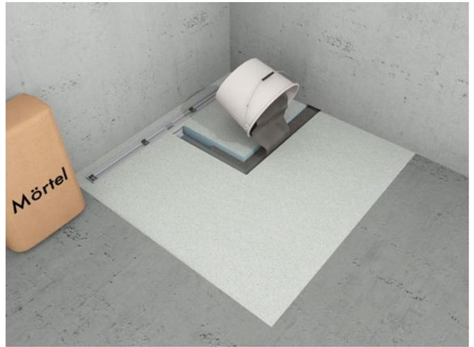
**6.** Mit Mörtel ist der Rohrkanal mit der weiteren Entwässerung zu vergießen.
