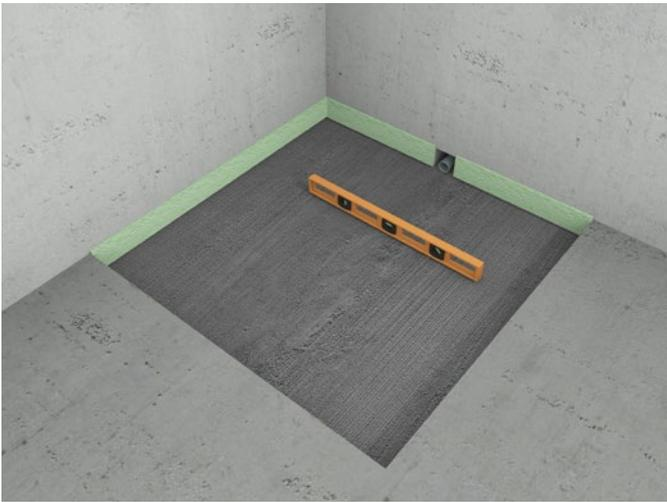
**1.** Herstellen eines planen, staubfreien Untergrundes. An den wandanliegenden Seiten des Duschelementes ist ein Randdämmstreifen anzubringen. Der Estrich sollte entsprechend größer ausgespart werden.
