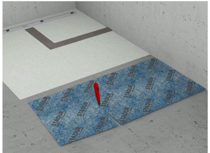
**8.** Mit der mitgelieferten Dichtbahn wird der aufgefüllte Kanal für die Rohrleitung abgedichtet. Diese kann auf die benötigten Maße zugeschnitten werden.
