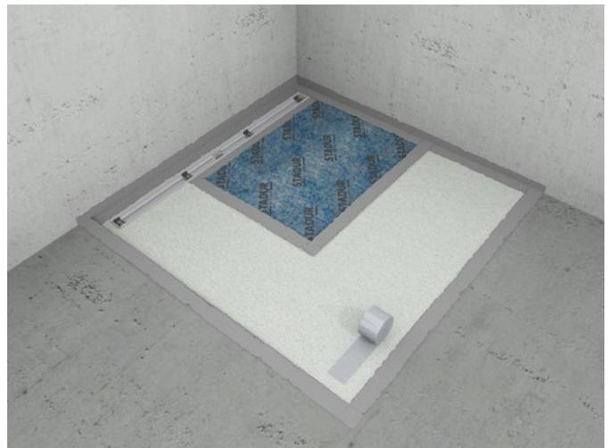
**10.** Die Übergänge Wand-Duschelement, Estrich-Duschelement und Dichtbahn-Element werden mittels flexiblem Dichtband abgedichtet. Im Anschluss werden die Stöße alternativ abgedichtet.
