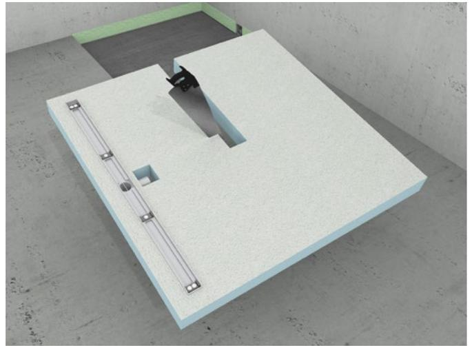
**2.** Mittels einer feinzahnigen Säge wird die Kanalführung für die Entwässerung herausgeschnitten.
