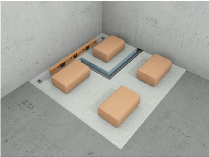
**5.** Das Duschelement ist gleichmäßig zu beschweren. Mittels Wasserwaage kann die Verarbeitung geprüft und gegebenenfalls angepasst werden. Die Rohrleitungen werden im Anschluss verlegt.
