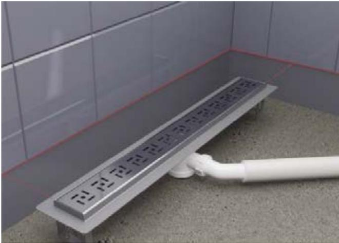
2. Platzieren des Ablaufes mit gleichzeitigem Anschluss an die Entwässerung, sowie die Schallisolierung der Abflussleitung. Dichtigkeitsprüfung vollziehen.
