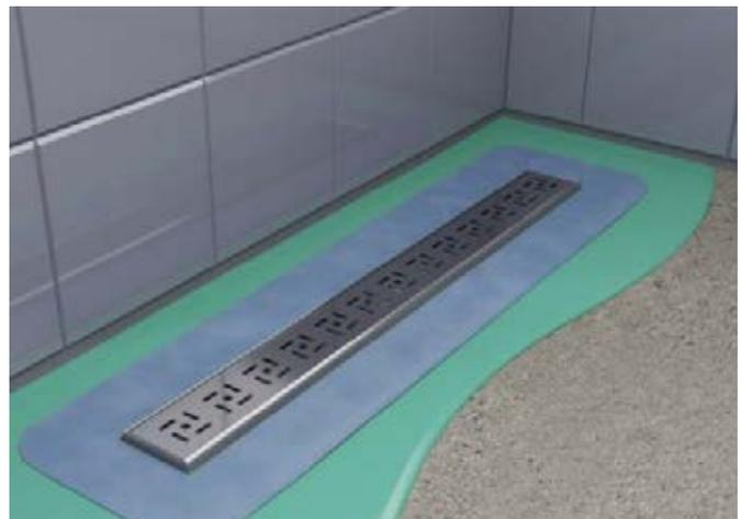
5. In die noch nicht ausgetrocknete Flächenabdichtung die mitgelieferte Dichtbahn einbetten.
