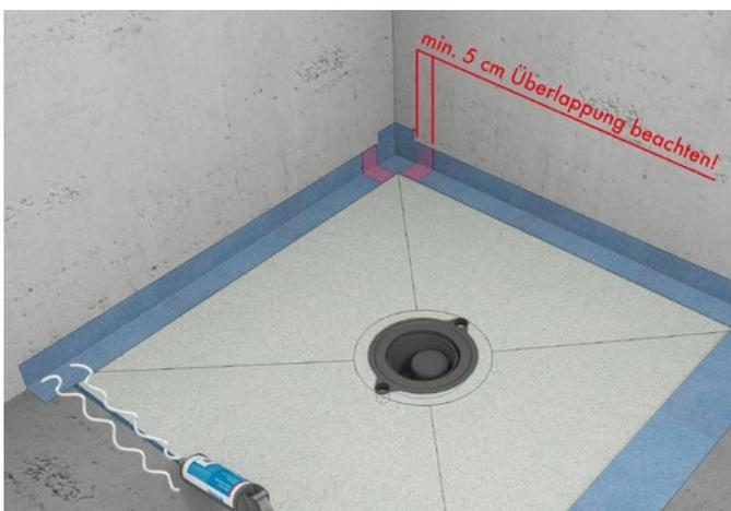
5. Dichtbahn anbringen (min. 5 cm Überlappung)
