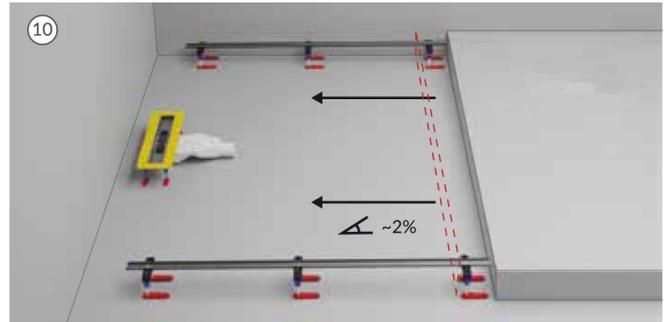
10. Nehmen Sie die Rinne vom Ablaufsockel ab. Schneiden Sie die Einbauführungen zu und bauen Sie diese an den geeigneten Stellen ein, um das richtige Gefälle des Duschbodens zum Ablauf zu gewährleisten. Das so entstehende Gefälle sollte ca. 2% (2 cm/1 m) betragen.
