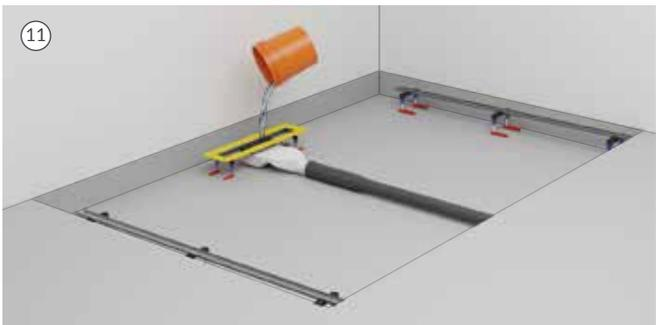
11. Schließen Sie den Duschablauf an das Abflusssystem an und prüfen Sie diesen auf Dichtigkeit.
