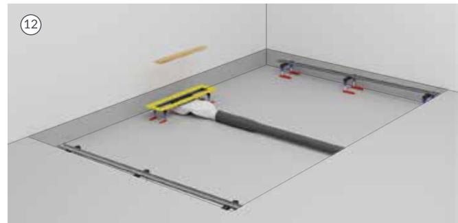
12. Setzen Sie die Pappabdeckung zum Schutz vor Zementmörtel und anderen Verschmutzungen in den Ablaufboden ein.
